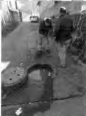
Ilustración 2 El 05 de febrero se realizó desazolve en calle Tamaulipas, Tepexoyuca.
