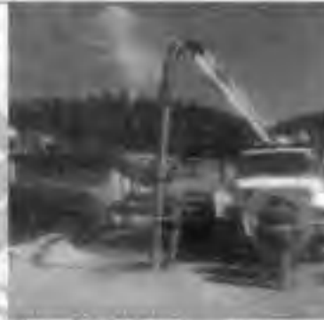
Ilustración 8 El 24 de marzo se realizó desazolve de la zona de Valles de la Marquesa y San Pedro Atlapulco
