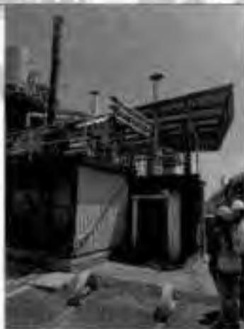
Ilustración 1 Visita de inspección de Diamond de México S.A. de C.V. 10/03/2024
