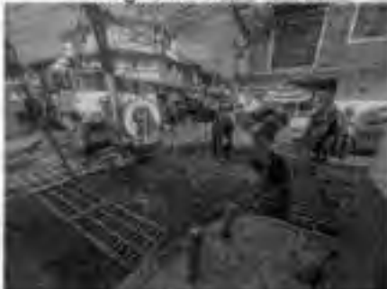
Ilustración 7 El 27 de febrero se realizó desazolve de alcantarillas en la Colonia Centro.
