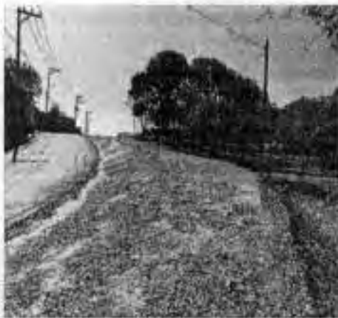
AMPLIACIÓN DE LA CALLE 5 DE MAYO, 1a ETAPA
