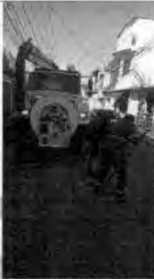
Ilustración 1 el 03 de febrero se realizó desazolve en calle Guadalupe Victoria esq. Quintana Roo, Coapanoaya.
