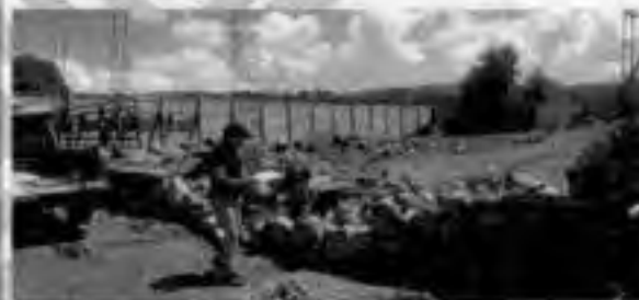
Vista de la visita de obra 25/03/2025
